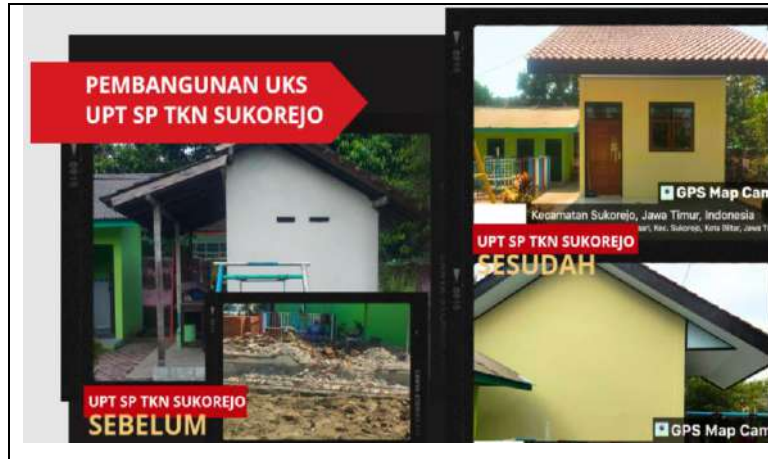
Gambar 3.1.2. Pembangunan UKS UPT SP TKN SUKOREJO
