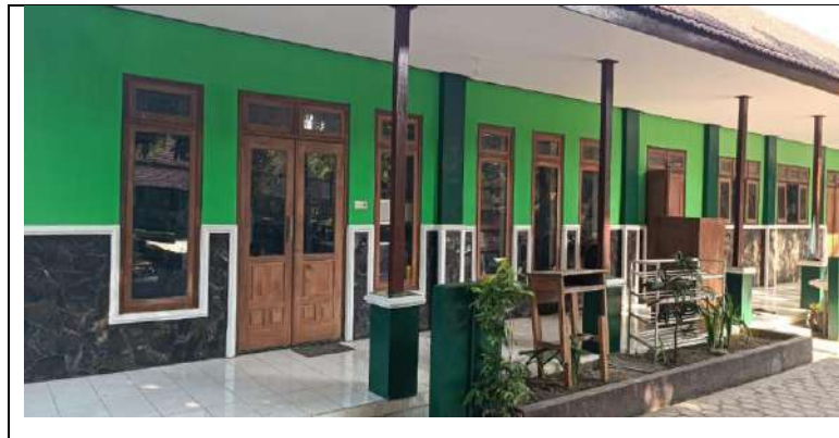
Gambar 3.1.8. Rehab Ruang Kelas SDN Karangtengah 1
