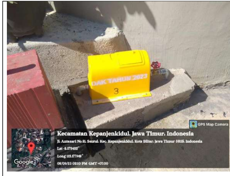
Gambar 3.3.2 Penambahan Sambungan Rumah SPAM di Kelurahan Tanggung
