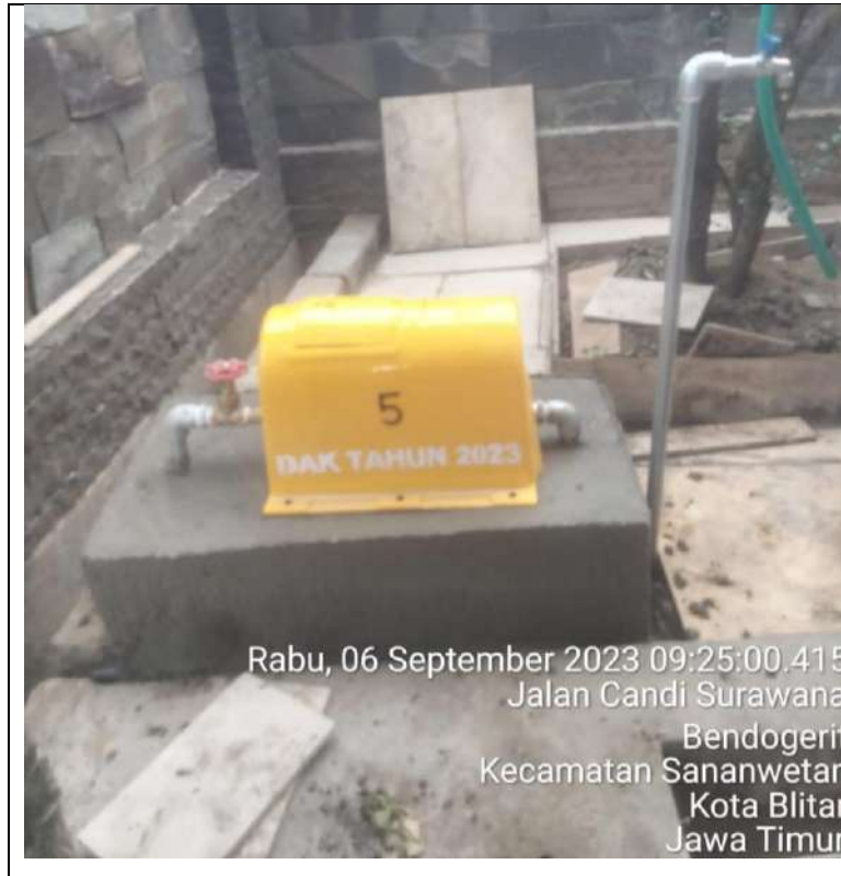
Gambar 3.3.1 Penambahan Sambungan Rumah SPAM di Kelurahan Bendogerit
