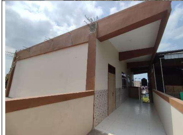
Gambar 3.1.15, Pembangunan RKB SMP Alam Al Ghifari
