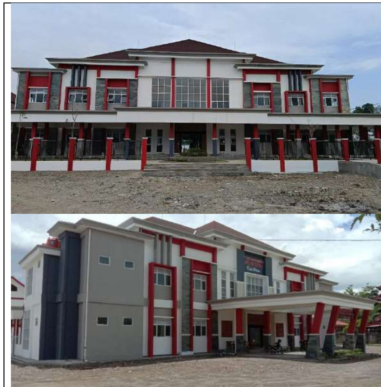
Gambar 3.1.13, Pembangunan SMPN 6 Kota Blitar
