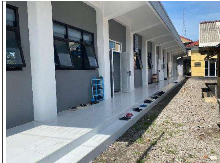
Gambar 3.1.14, Pembangunan RKB SMP Muhammadiyah 2
