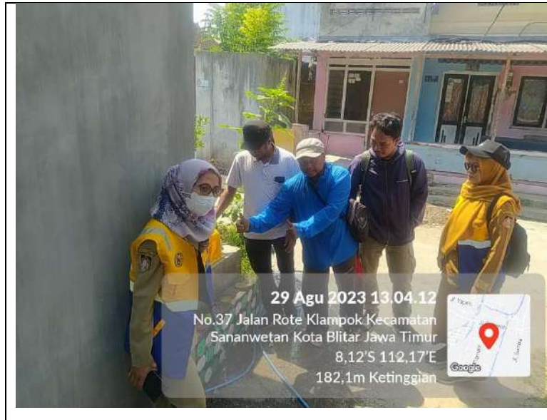
Gambar 3.3.3 Penambahan Sambungan Rumah SPAM di Kelurahan Klampok
