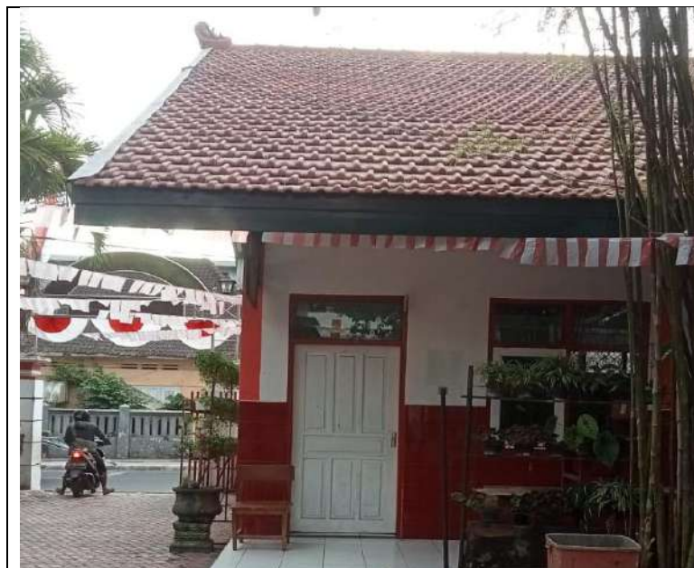
Gambar 3.1.10. Rehabiliatsi Ruang Kelas
